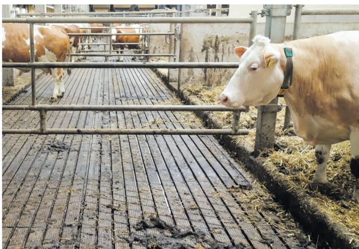
Der Rillenboden aus Beton wird mit einem Kammschieber entmistet. Man kann auch Gummimatten oder Verbundsysteme mit Beton einsetzen.
